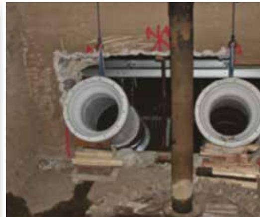
*Montage terminé et début du scellement des aspirateurs béton.*
