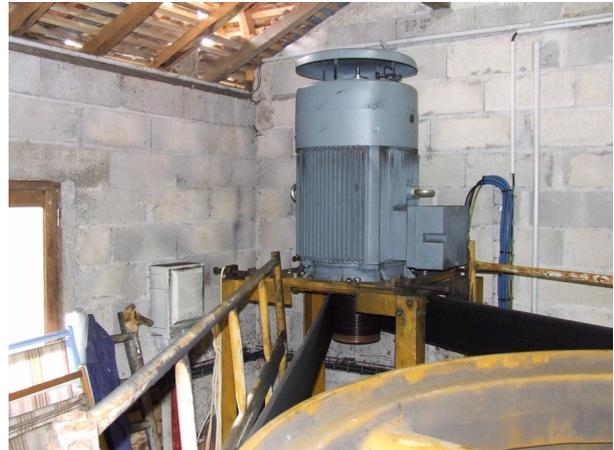
Là, c'est une installation de 50 kwatts avec une turbine Francis. L'appareillage est couplé au réseau, un générateur de 55 kwatts. Il y a deux coffrets : un petit pour la régulation électronique et toutes les sécurités couplage découplage et un coffret électrique avec toutes les fonctions dévolues à l'EDF.
