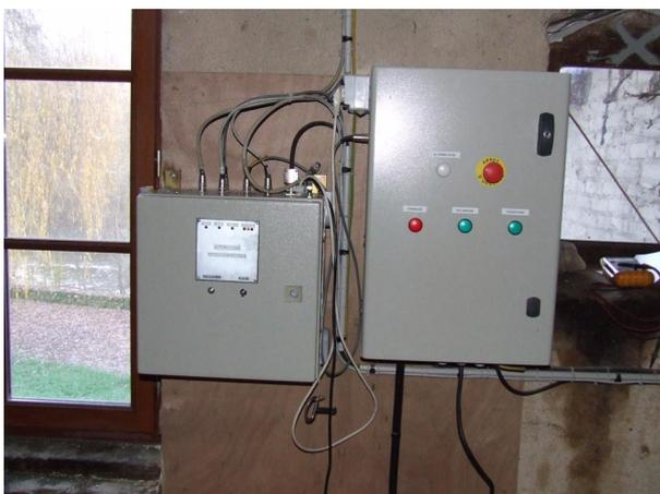
Ca, c'est une installation dans les Deux-Sèvres qui fait 25 kW, c'est une turbine à cloche l'électronique de régulation qui ouvre plus ou moins la cloche en fonction du
