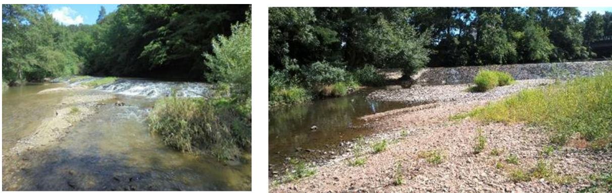
Figure 35 : seuils dépourvus de vannes dans le département de la Loire.
