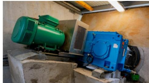
Cette centrale a une puissance installée de 735 kW. Elle est en réalité composée de 2 centrales : Les Forges (1 groupe Kaplan et 1 groupe Francis sous hauteur de chute 4.22 m / puissance 660 kW) et la Vis (au seuil de 75KW sous 3,41m de hauteur de chute).
